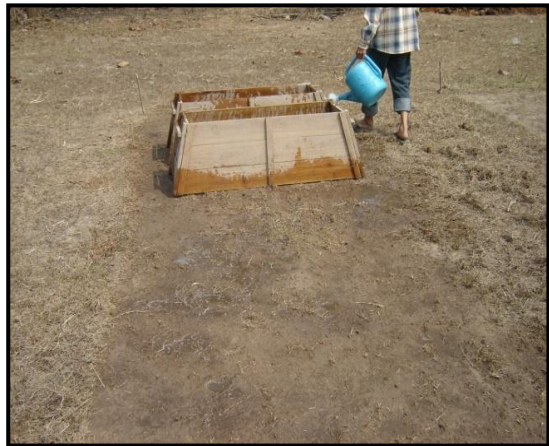
ภาพ เตรียมพื้นที่และตั้งแบบพิมพ์
